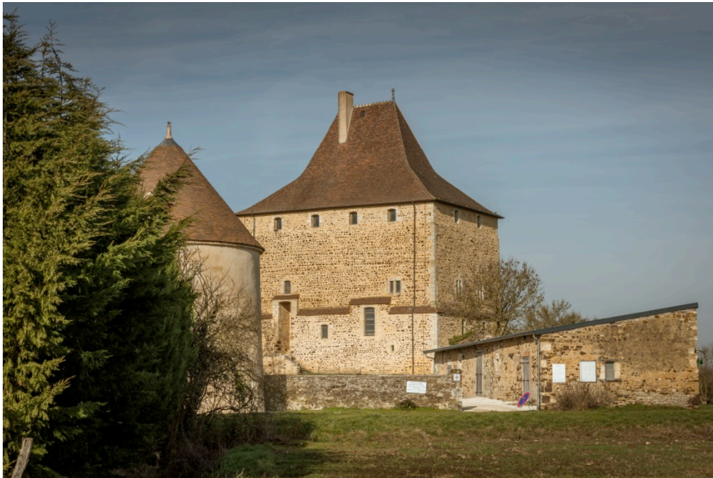
Site historique de la Tour de Vesvre (Source : latourdevesvre.fr)
