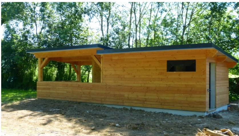
Construction de type auvent/bar, étang de Neuvy-deux-Clochers (source : site communal)
