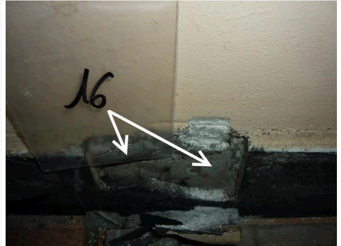
Composant : Colle des carrelages 16 (N) colle grise sous plinthe 10x10cm noire Cellule 9 homogène avec cellule 7 (ZPSO 7)
