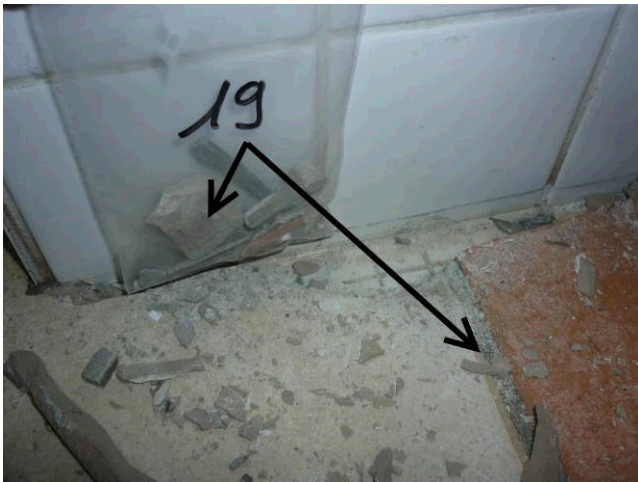
Composant : Colle des carrelages 19 (N) colle grise sous carrelage 30x30cm beige + joint gris Colle grise sous carrelage 30x30cm orange (C5, C9), beige (C5, C8) ou avec motif (C5). Cellule 8 homogène avec les cellules 5, 9 (ZPSO 5)
