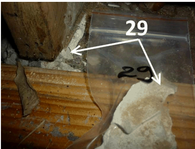
Composant : Colle 29 (N) colle blanche sur lambourde (sous plancher bois) Cellule 3
