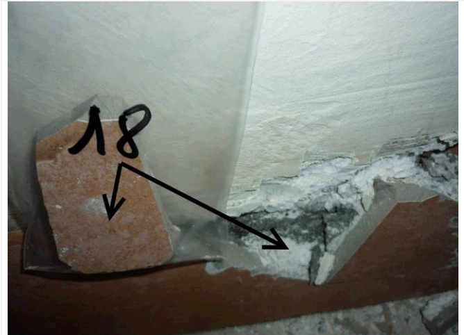
Composant : Colle des carrelages 18 (N) colle blanche sous plinthe 30x10cm orange Cellule 8 homogène avec cellule 5 (ZPSO 6)
