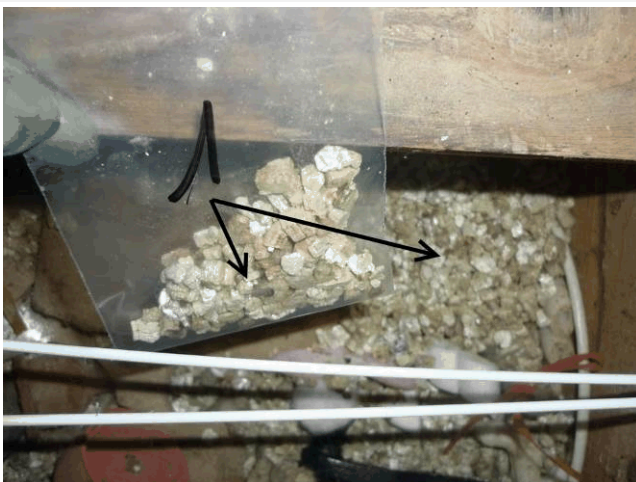
Composant : Éléments ponctuels et Accessoires de toiture 36 (N) isolant granulé beige Cellule 18 homogène avec les combles (ZPSO 1)
