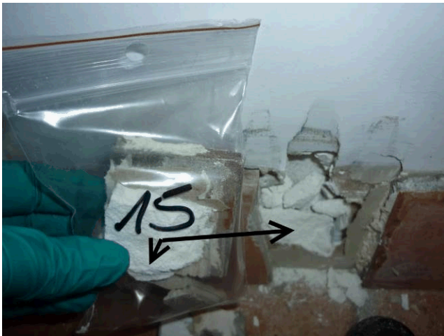
Composant : Colle des carrelages 15 (N) colle blanche sous plinthe 30x10cm orange + joint gris Cellule 5 homogène avec cellule 8 (ZPSO 6)
