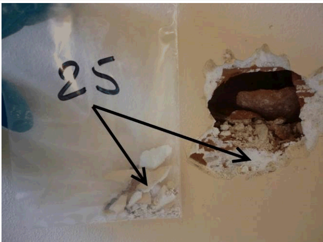
Composant : Peinture ou enduit 25 (N) enduit plâtre + peinture beige sur cloison brique (mur) Cellule 7 homogène avec les cellules 5, 8, 9, 10, 11 (ZPSO 11)
