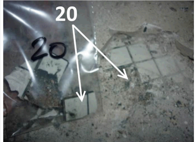
Composant : Colle des carrelages 20 (N) colle grise sous carrelage 2x2cm blanc + joint gris Cellule 8 homogène avec cellule 7 (ZPSO 9)
